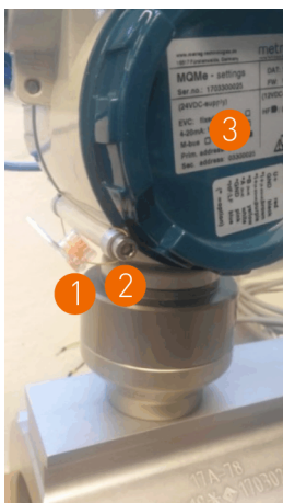
Abb. 8 Verplombung und Sicherungsschraube
